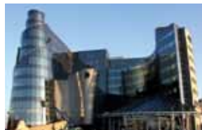
Офисное здание TVP - Варшава
