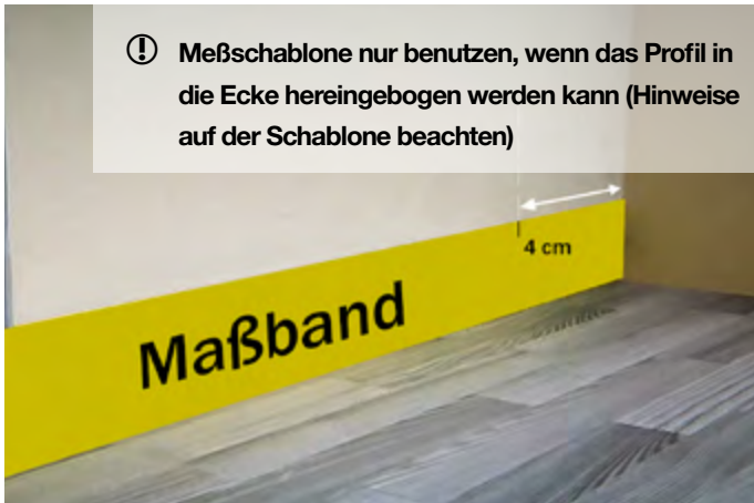
Maßband glatt an der Wand bis in die Innenecke
