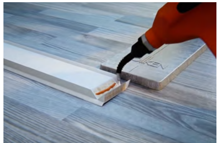
In den Schnitt Döllken Heißschmelzkleber auftragen . . .
