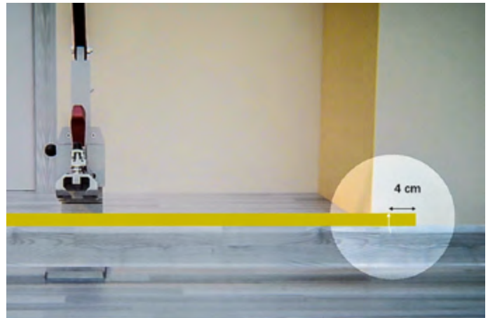
4 cm von der Innenecke zurück auf der Sockelleiste anzeichnen
